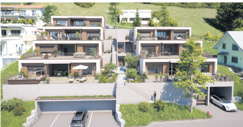
An schöner, sonniger Lage entstehen hier in Mettau sieben Terrassenhäuser. Der Bezug ist für Ende 2025 geplant. Visualisierung: zVg
